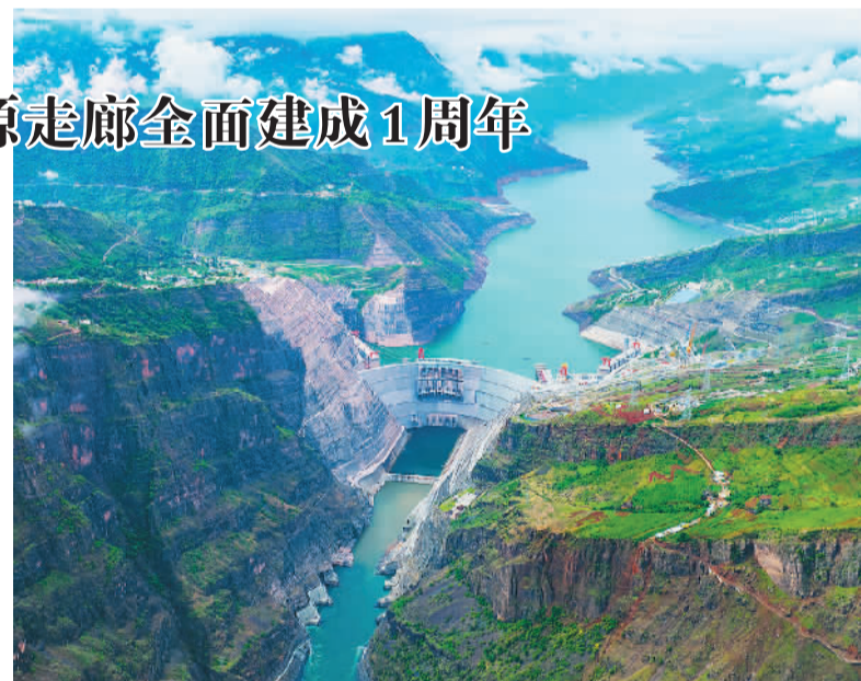
白鹤滩水电站工程全景。
