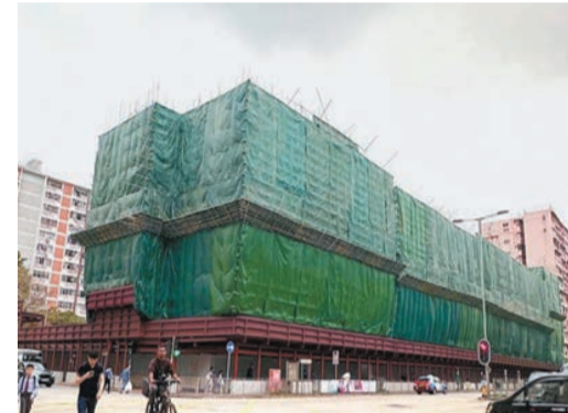
盛德街項目地盤正進行清拆工程，重建後可提供約640個住宅單位。
