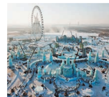
◆12月14日，工人在哈爾濱冰雪大世界圍區建設現場施工。
