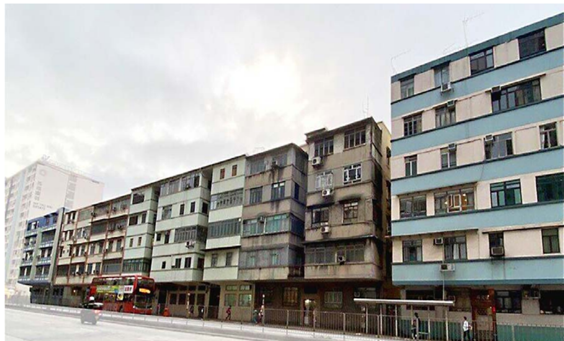
市建局九龍城盛德街/馬頭涌道發展項目原址為公務員建屋合作社地段。
