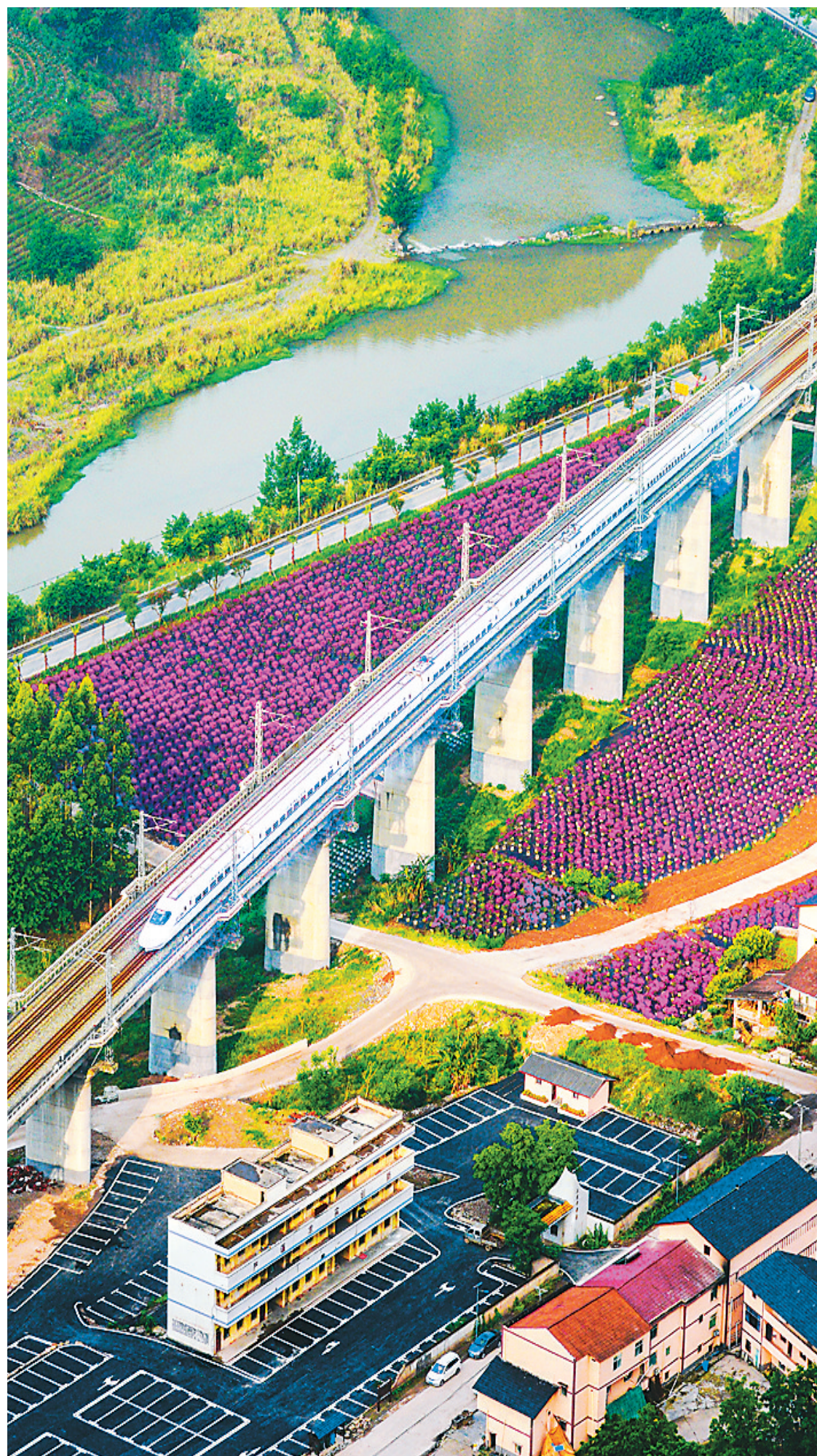
▲ 动车组列车穿过绿春坝。
