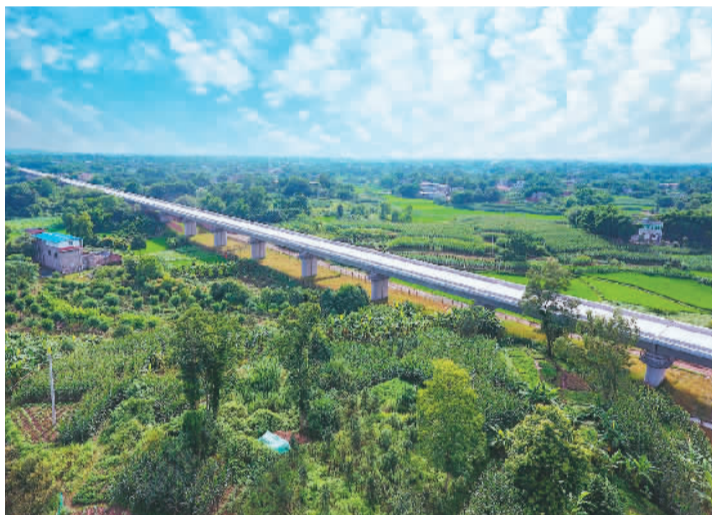
作为国家“八纵八横”高铁网主通道之一的京昆通道的重要组成部分，渝昆高铁全长699公里，设计时速350公里。目前，渝昆高铁川渝段箱梁已全部架设完成。图为中铁十二局渝昆高铁川渝段站前三标项目部建设的箱梁架设成型段落。唐毅摄
