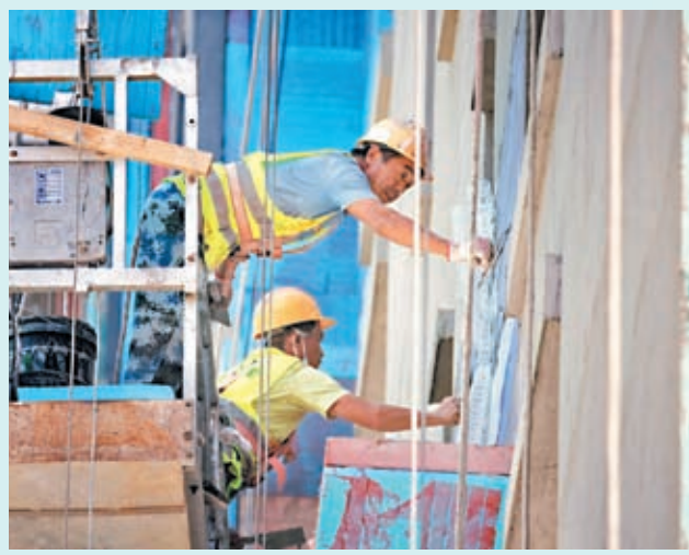
◆有內房企因為缺乏融資，拖欠施工企業款項，令施工進度受阻。資料圖片
