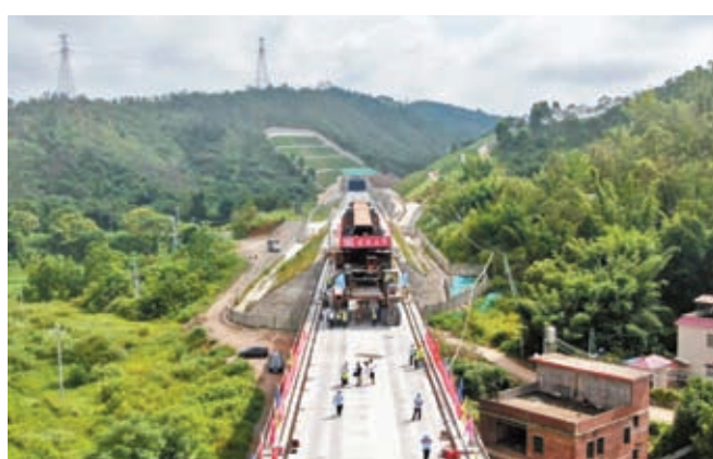
◆梅龍高鐵路施工現場。香港文匯報廣東傳真
