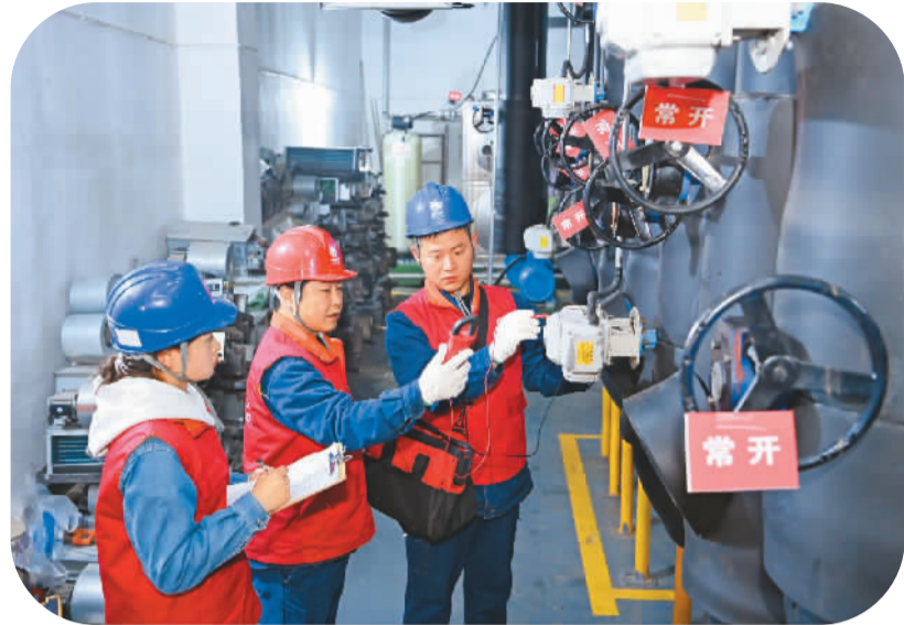
11月28日，安徽省滁州市供电公司工作人员在该市南谯区一处热力站对供暖用电设备进行检修。 宋卫星摄（人民图片）
