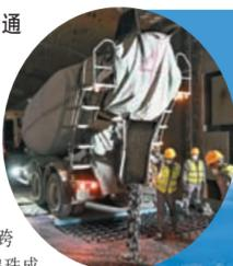
◀工作人員在深中通道海底沉管隧道內澆築最後一節壓管混凝土。中新社
