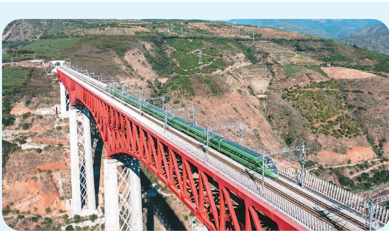
图①：11月23日，“复兴号”列车通过中老铁路元江特大桥。
