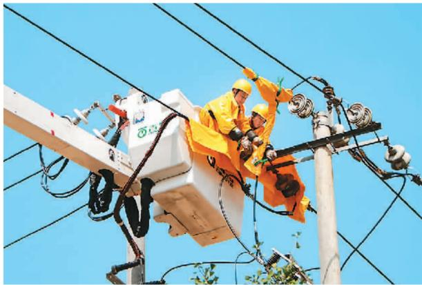
近日，南方电网贵州遵义凤冈供电局配网带电作业班顺利完成10千伏凤城Ⅱ回和Ⅳ回线路升级改造工作，本次“带电作业”实现客户“零感知”，有效保障了居民迎峰度冬期间安全稳定用电。肖晓 摄
