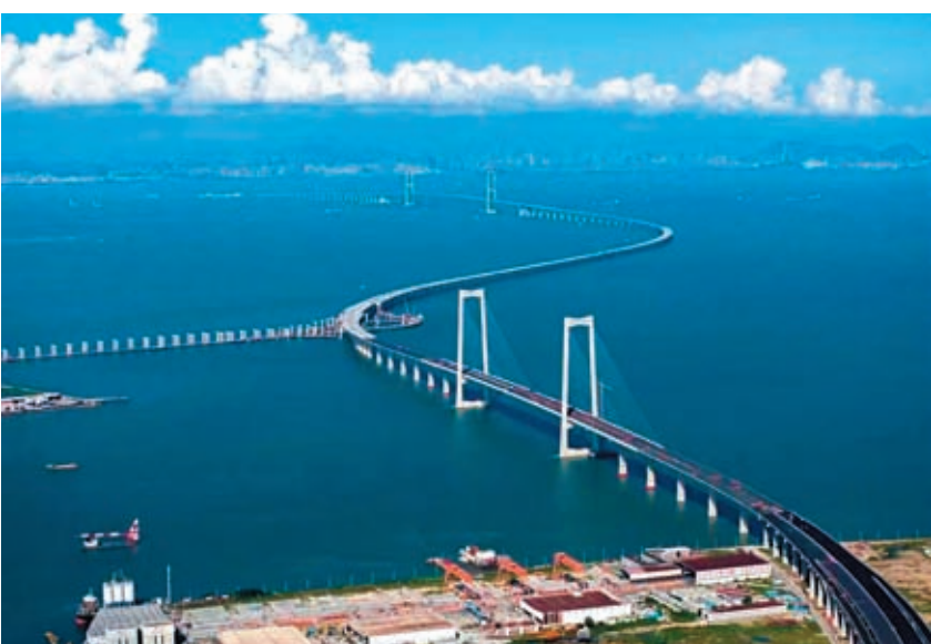
◆深中通道正在加速建設，力爭明年全線建成通車。
