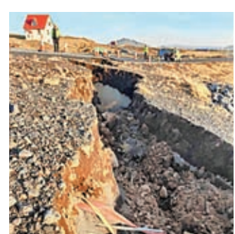
格林達維克鎮周圍多處地表開裂。
