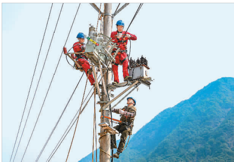
为保障群众生产生活用电更加安全、稳定和可靠，国网浙江省丽水市供电公司供电人员近日开展电网设备和线路检查工作，及早发现和治理电网可能存在的问题。图为供电人员在工作。褚津津摄
