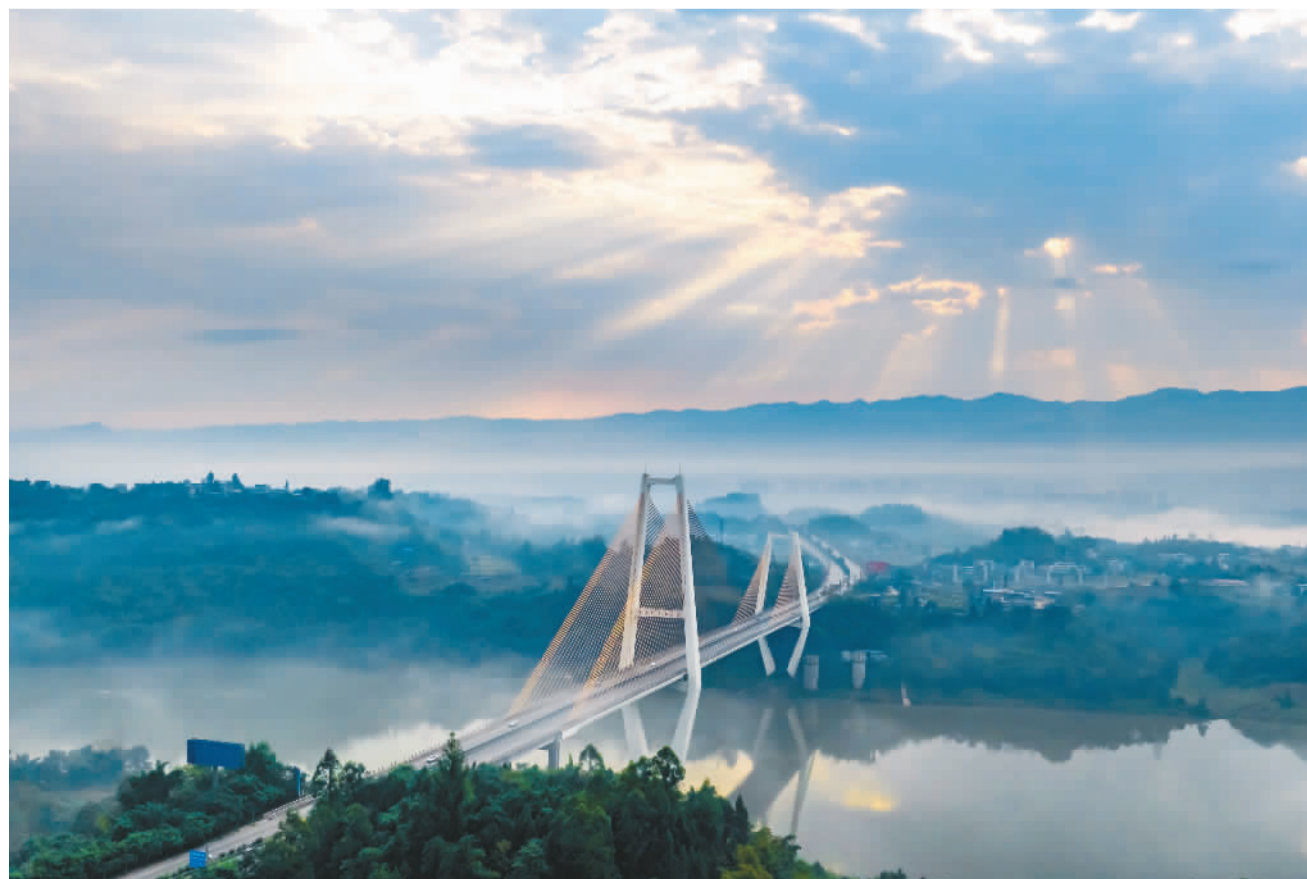
清溪口渠江大桥是四川省华蓥至广安快速通道跨渠江的一座双向四车道特大型桥梁,全长669.56米。图为11月7日清晨,霞光下的清溪口渠江大桥。邱海鹰摄(人民视觉)
