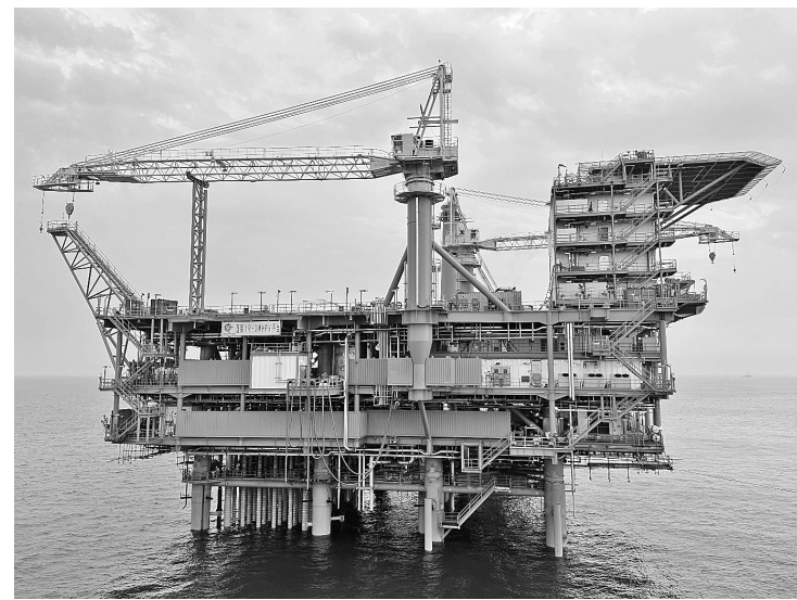
中国首个永磁电潜泵全覆盖的海洋石油平台——蓬莱19-3油田5/10区开发项目H平台。
