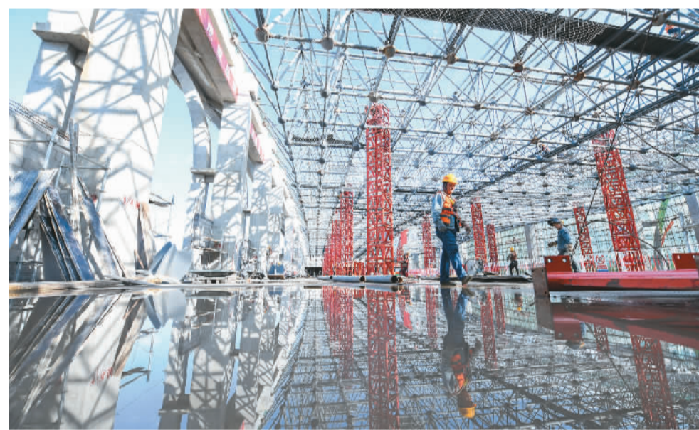
中国北高铁站——黑龙江伊春西站今年9月完成封顶。该站为哈伊高铁线上站点，线路全线通车后，将加强黑龙江省与内陆发达地区的经济联系，促进东北老工业基地振兴。图为工人在伊春西站施工现场作业。新华社记者 王松摄
