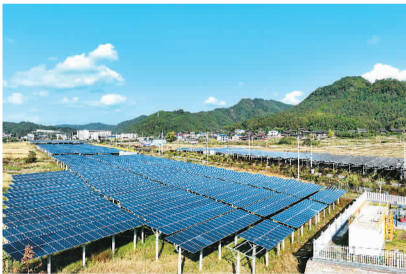
湖南省通道侗族自治县立足当地光热资源优势，大力推进光伏产业发展，目前已建成帮扶式光伏电站6座，总装机容量约7700千瓦。图为通道侗族自治县溪口镇光伏电站一景。李尚引摄（人民视觉）
