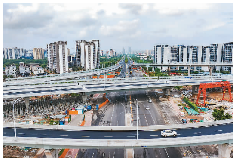
10月29日，海南省海口市美兰国际机场快速通道项目实现主线桥通车。作为海南自贸港建设重点民生工程，美兰国际机场快速通道项目由海口市路桥建设投资有限公司建设、中铁上海工程局集团施工，总投资额21.19亿元，路线全长约5.37公里，项目建成后有效提升区域通行便利度。元明摄（人民视觉）
