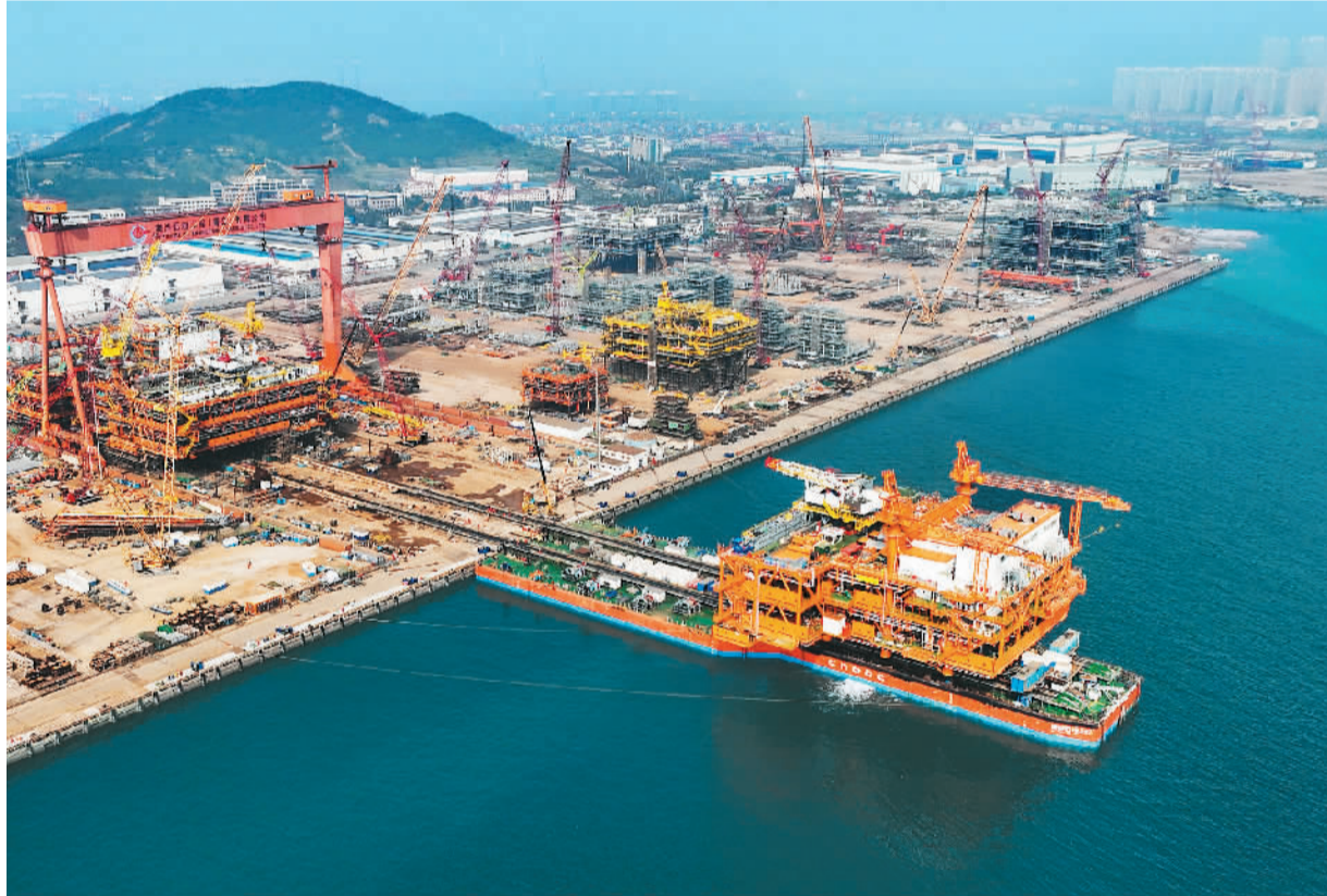
10月26日,埋北油田中心平台在山东青岛完工装船,随后将赴渤海西部海域,进入海上安装和调试阶段。这一平台总重量近15000吨,将高压输电设备与油气处理模块共建在同一平台上,实现岸电的引入,这是该模式在国内的首次尝试。图为埋北油田中心平台。杜鹏辉摄(新华社发)
