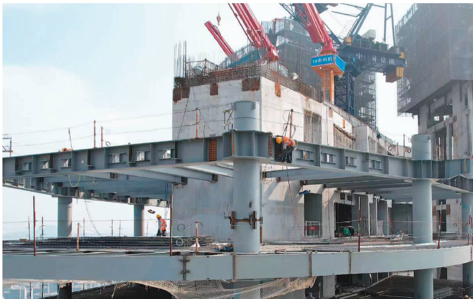
近日，在中建八局建设的广州中新知识塔项目上，建设人员正在开展主体和机电安装作业。据悉，该项目是中国、新加坡两国合作的标杆项目，高度达330米，建筑面积40.1万平方米，建成后将成为中新双方合作的重要载体。
