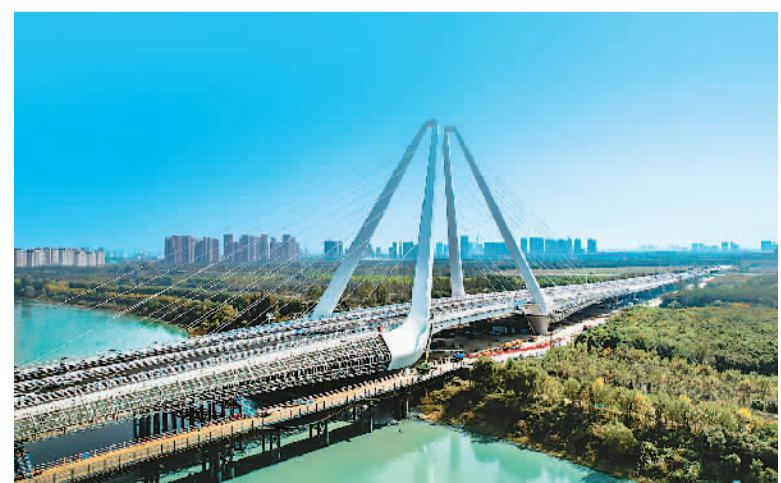
近日,由中建八局承建的陕西咸阳渭河高新大桥正式通车。作为陕西省重点基础设施建设项目,咸阳渭河高新大桥北起咸阳高新区高科一路,向南跨越渭河,连接沣西新城中国西部科技创新港,主线全长约1.8公里。大桥通车将大幅改善两地通勤情况,推动西咸地带创新驱动发展。图为咸阳渭河高新大桥一景。孙启平摄(人民视觉)
