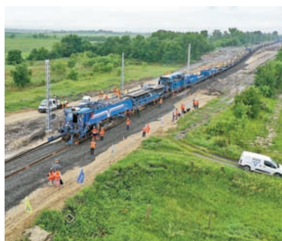
◆這是5月30日拍攝的匈塞鐵路匈牙利段孔聖米克洛什-陶什站施工現場。
