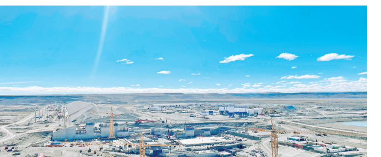
图为中国能建葛洲坝集团阿根廷“基塞”水电站项目施工现场。
