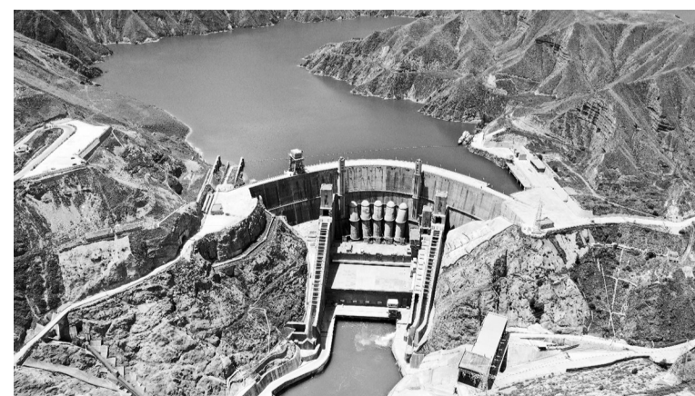
图为李家峡水电站。(资料图) 李鑫业 摄
