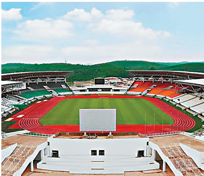
◆中國土木承建的科特迪瓦聖佩德羅體育場項目竣工移交。
