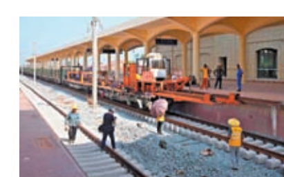
◆圖為鋪軌車在東興市站7道進行鋪軌作業。網上圖片
