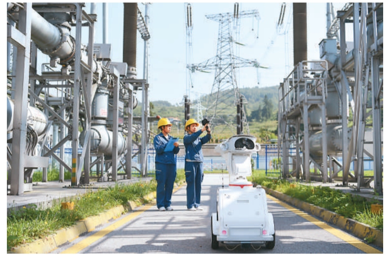
中秋国庆假期期间，全国各地不少劳动者坚守在岗位上，在忙碌中度过假期。图为9月30日，南方电网贵州六盘水供电局工作人员与智能巡检机器人配合，对500千伏电网枢纽变电站开展特巡特维。 李 泵摄（人民视觉）
