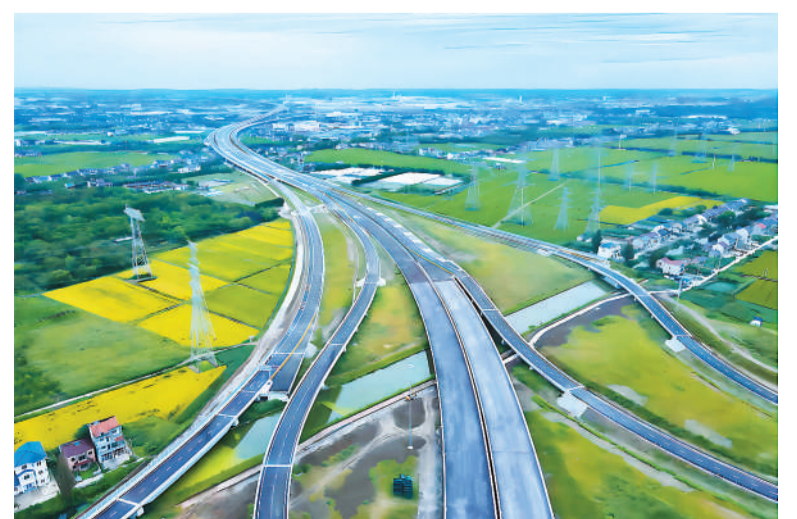
近日，由上海城投公路投资（集团）有限公司投资建设、中建八局土木公司等单位参建的上海S3公路建成通车。该道路是上海高速公路及沿海大通道的重要组成部分，全长约26.6公里，设计时速100公里，建成后助力上海自贸试验区临港新片区完善“陆海空铁水”汇聚的综合交通体系。 王泽文摄（人民视觉）
