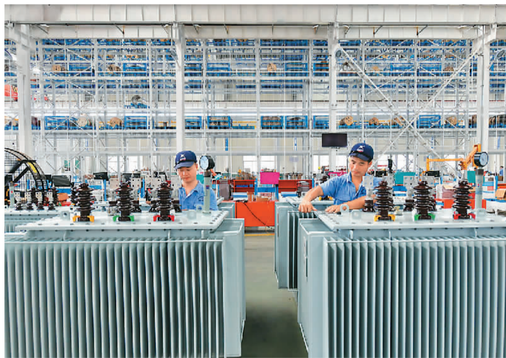
近年来,江西省抚州市崇仁县在发展变电设备产业过程中,把工业互联网、大数据等新技术、新模式运用在工业研发设计、生产制造、售后服务等方面,不断加快变电设备产业转型步伐。图为在崇仁县高新区正电电器智能化生产车间内,工人正忙着组装出口非洲国家的变压器订单。朱海鹏摄(人民图片)
