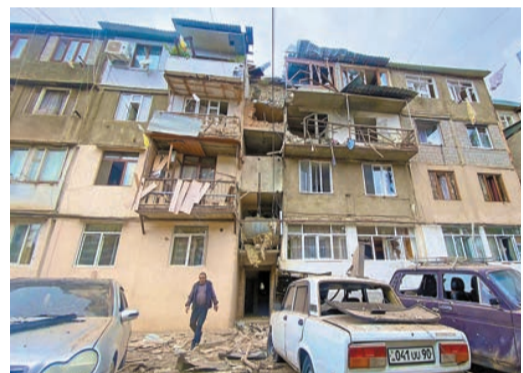
在納卡地區，一幢建築物在行動中遭到破壞。路透社
