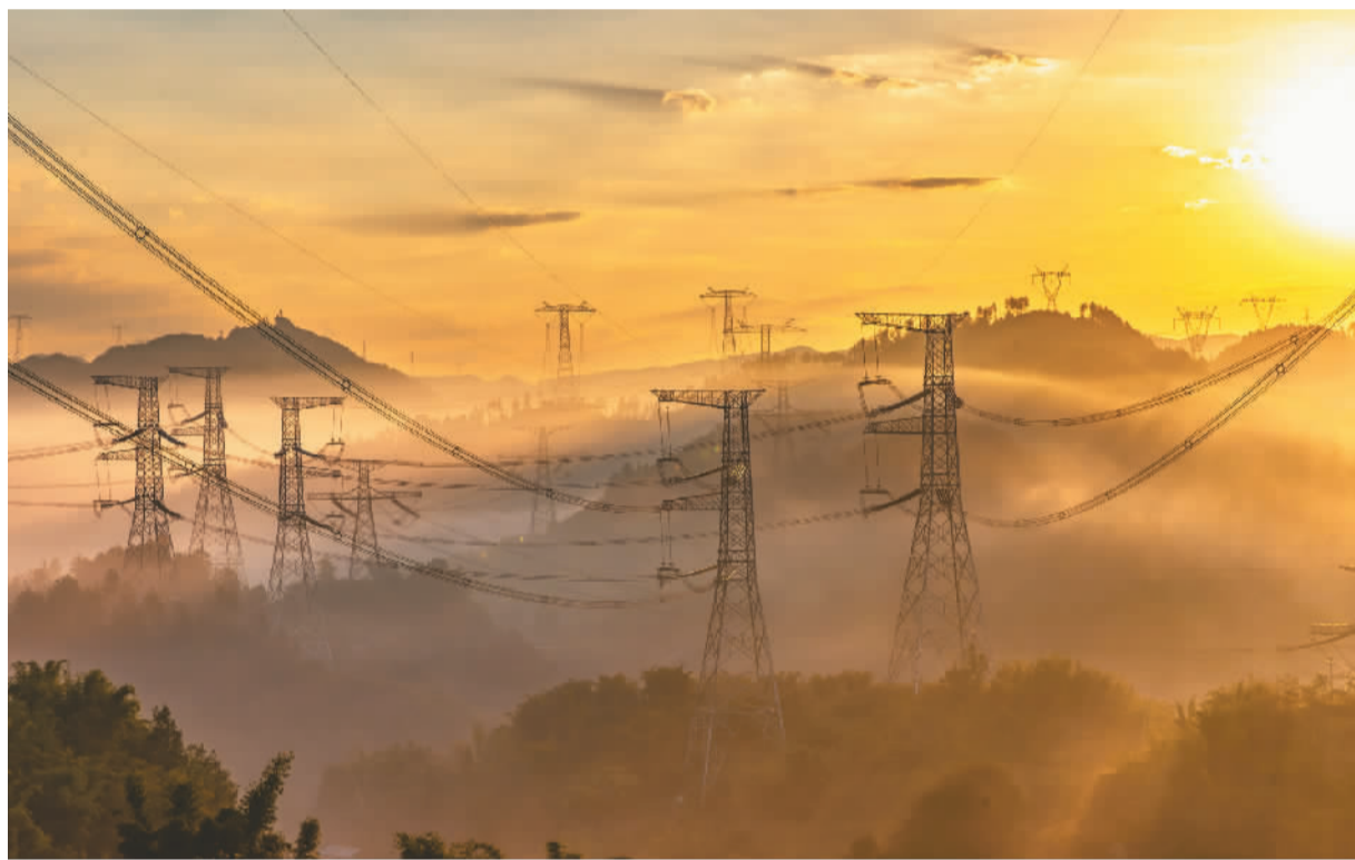
随着中国经济不断发展，越来越多的特高压输电线路在重庆市南川区境内翻山越岭、飞跃河流，将西部地区的电能输送到东部地区。图为位于重庆市南川区的特高压±800kV白鹤滩—浙江与白鹤滩—江苏两条输电线路。瞿明斌摄（人民视觉）
