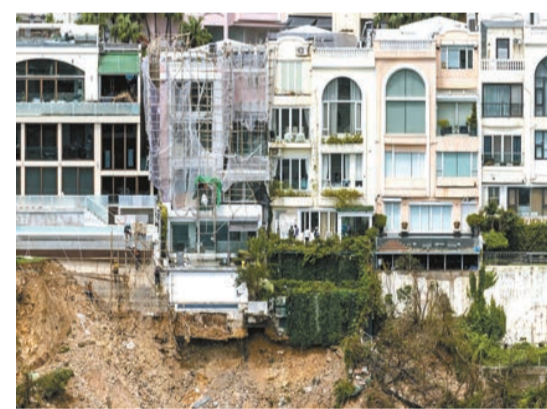
屋宇署人員到紅山半島視察，工人在塌山泥位置搭建棚架加固。
