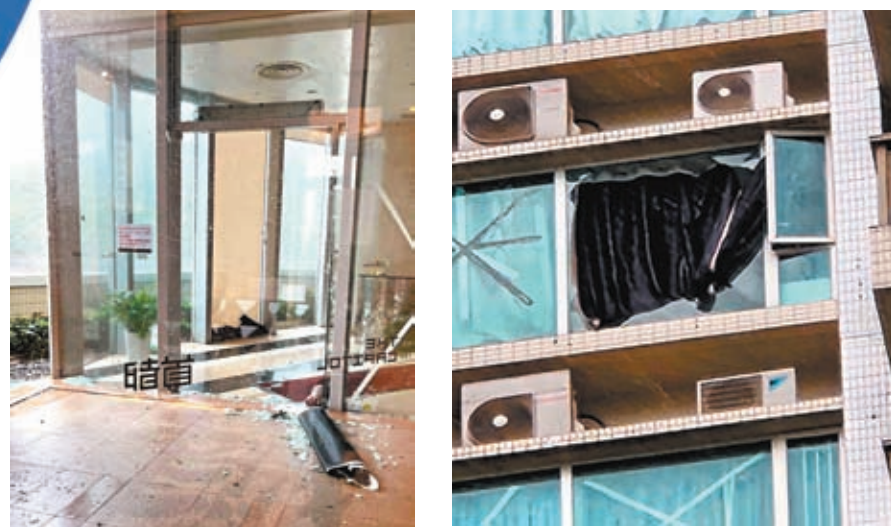
◆風暴期間有樓宇大堂和住戶的窗戶爆裂，玻璃碎片散落一地。
