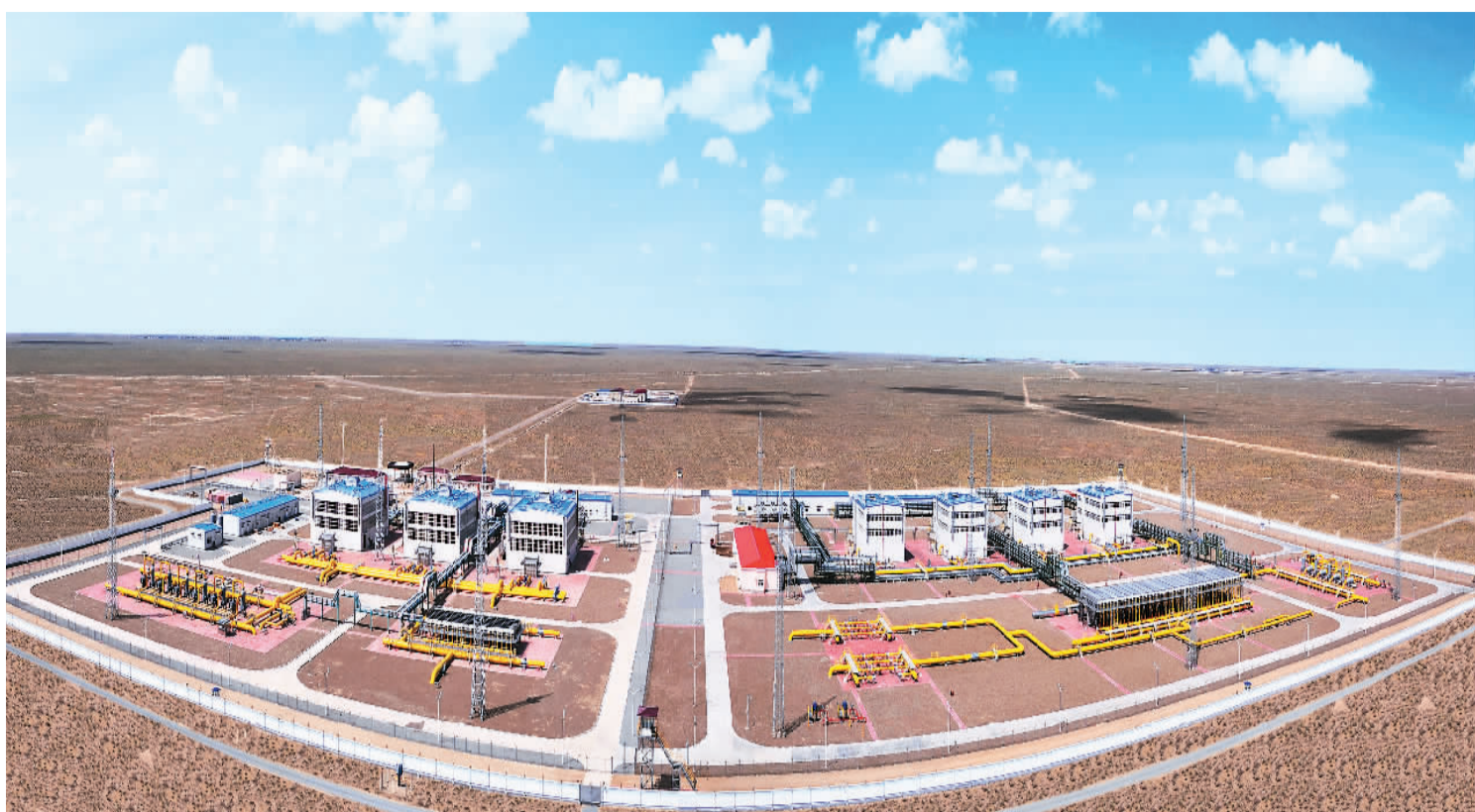
中乌天然气管道合资公司压气站。
