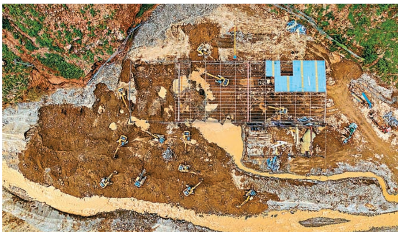
8月30日，救援人員在位於金陽縣境內蘆稿林河下游的蜀道集團沿江高速JN1（金寧一）標段項目部鋼筋加工場民工駐地附近實施救援（無人機照片）。
