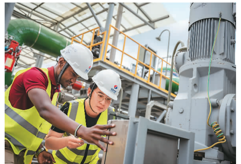
在位于肯尼亚纳库鲁市的索西安地热电站项目建设现场，施工人员检查发电设施。 新华社记者 王冠森摄
