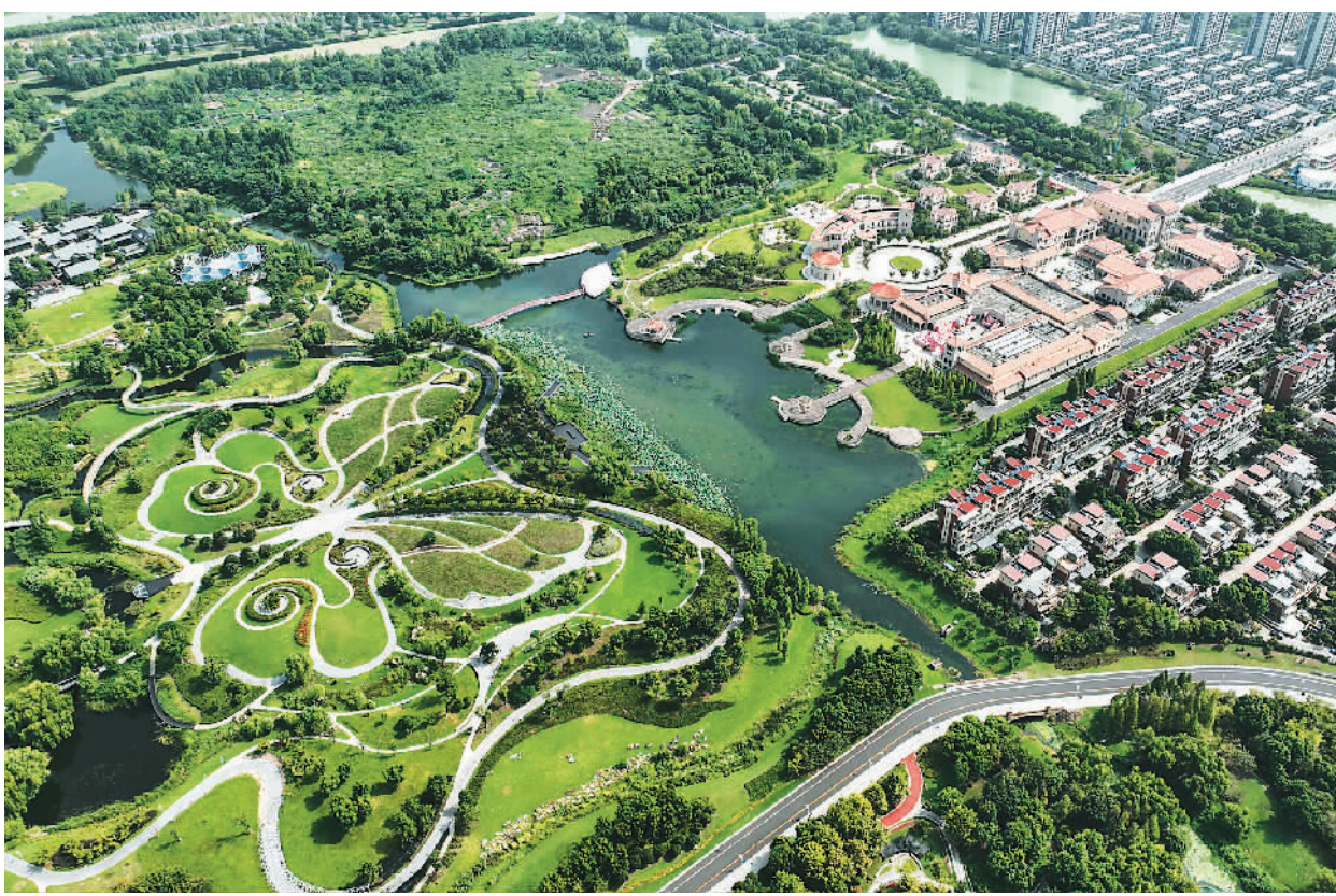
浙江省湖州市八里店镇在“千万工程”和“八八战略”的指引下,不断推进乡村建设和环境整治,乡村风貌发生巨大变化,形成“城乡促融合、全域创和美”的局面。图为位于八里店镇的西山漾国家城市湿地公园和周边的居民区。 新华社记者 翁忻昶摄
