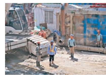
◆建造業輸入勞工計劃首輪僅獲26份申請。圖為香港建造業人員於工地工作。中新社
