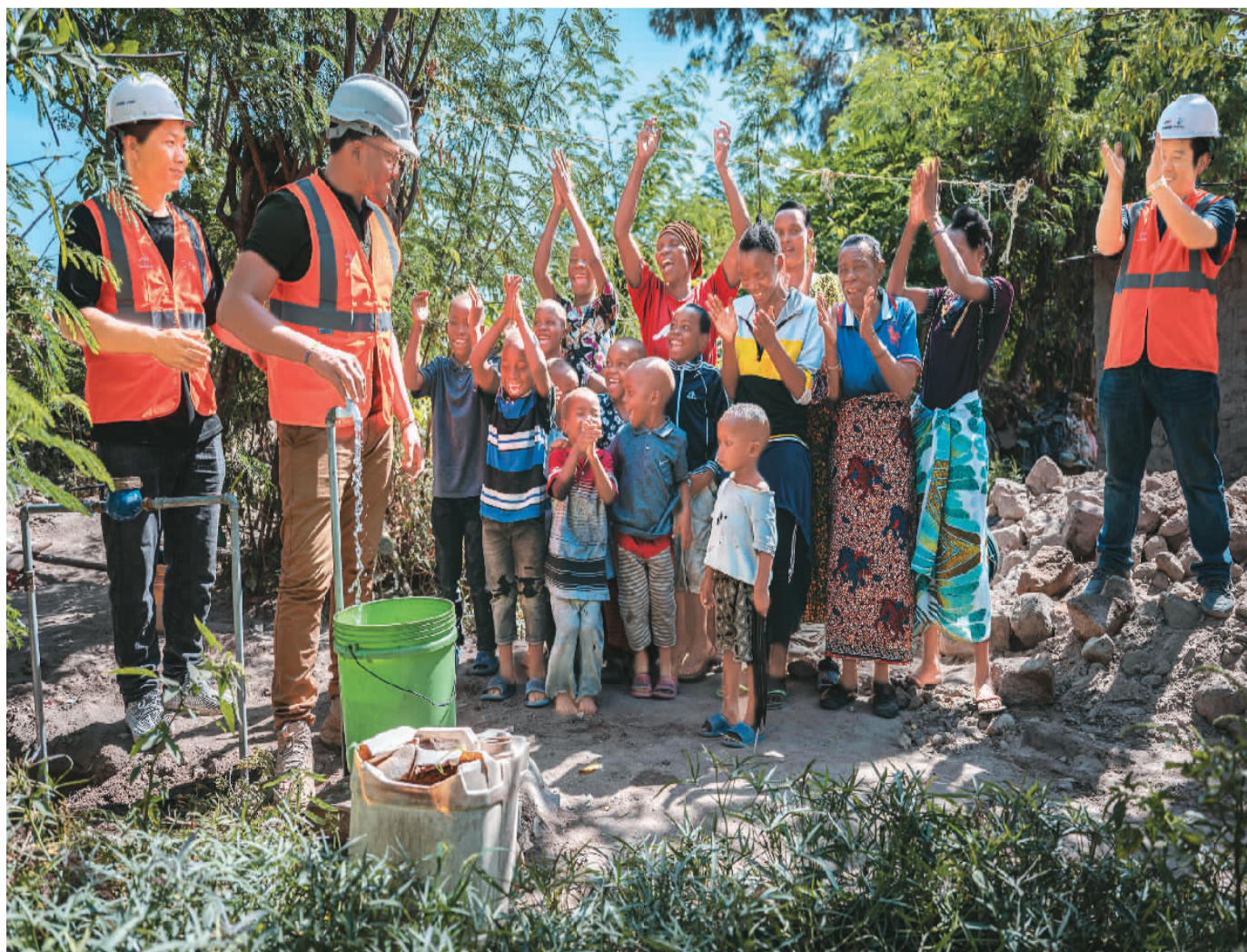
▲姆万扎省拉马迪的供水项目取水泵站。
