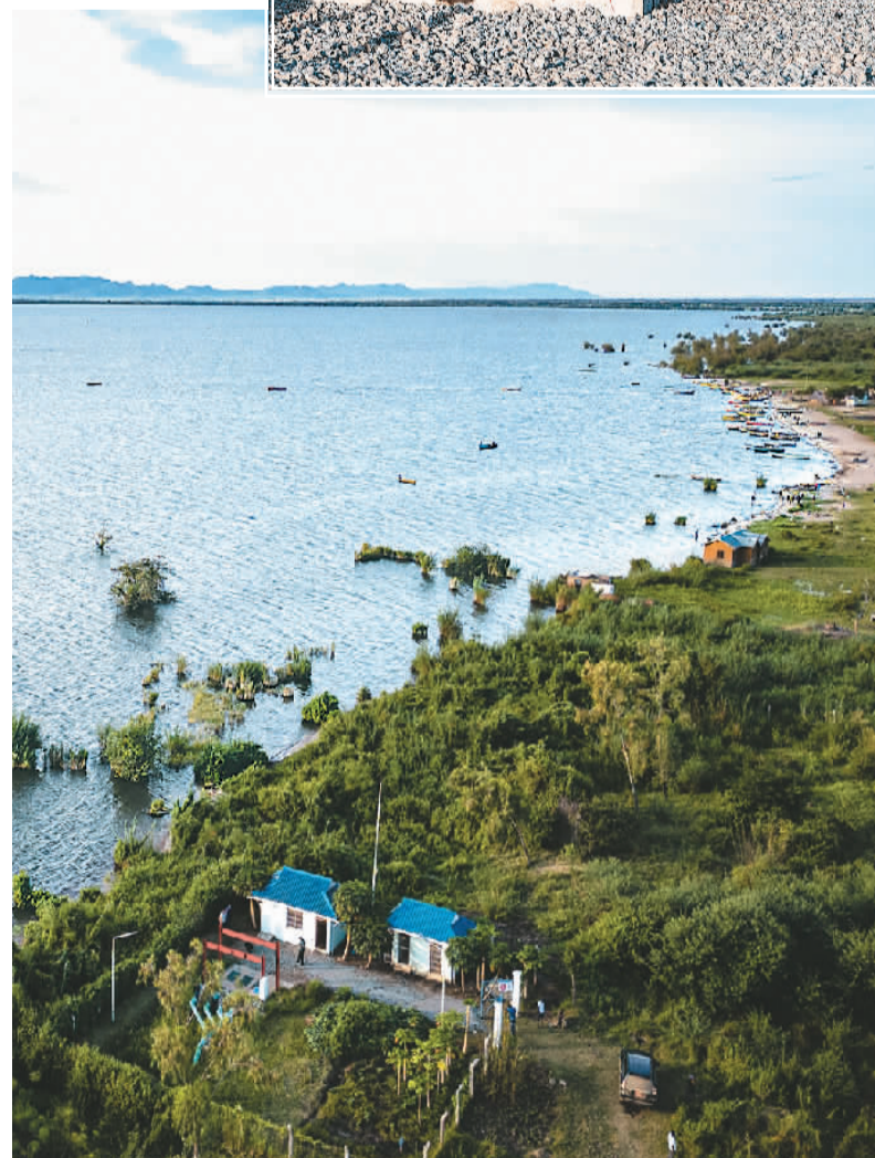
▲姆万扎省拉马迪的供水项目取水泵站。
