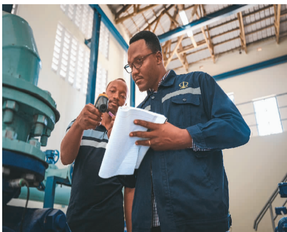
▲凯尔文（右）在位于姆万扎省奇塞凯的供水项目增压泵站记录水泵工作情况。
