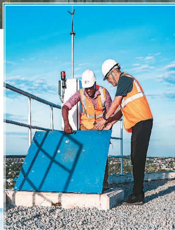
►凯尔文（左）与同事在布斯韦卢检查供水项目高位蓄水池。
