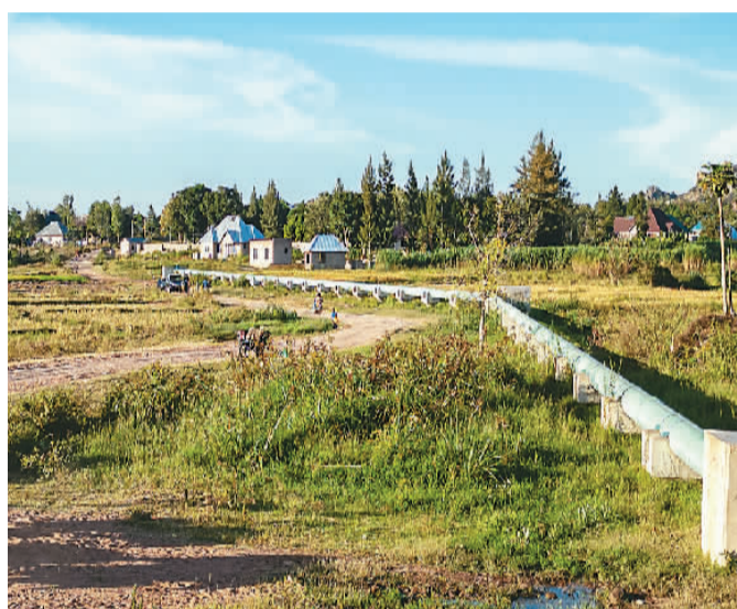
▲姆万扎省萨哈的供水项目输水管道。
