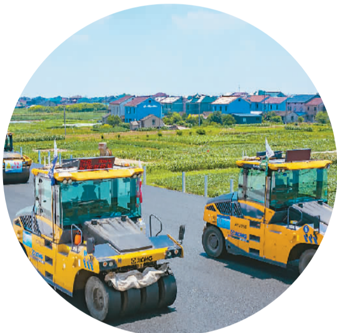
在浙江交通集团杭甬复线宁波一期项目浙江省慈溪市周巷段施工现场，由1台摊铺机、6台压路机组成的“无人驾驶施工集群”在进行沥青摊铺施工。 章勇涛摄（人民图片）
