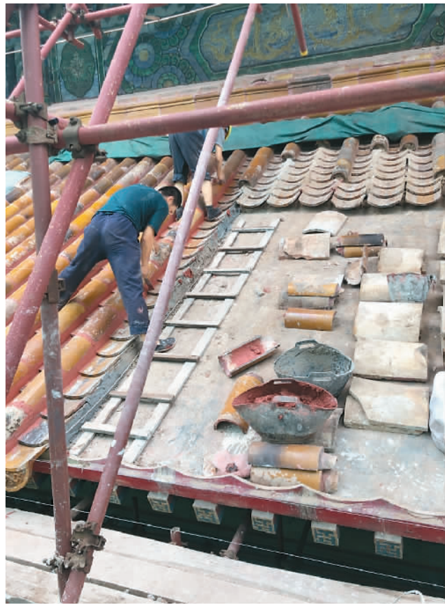
明十三陵景区内，工作人员在修缮相关建筑的屋顶。
