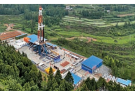
◆ 7月20日，中國首次在四川盆地開鑽萬米深井——「深地川科1井」。
