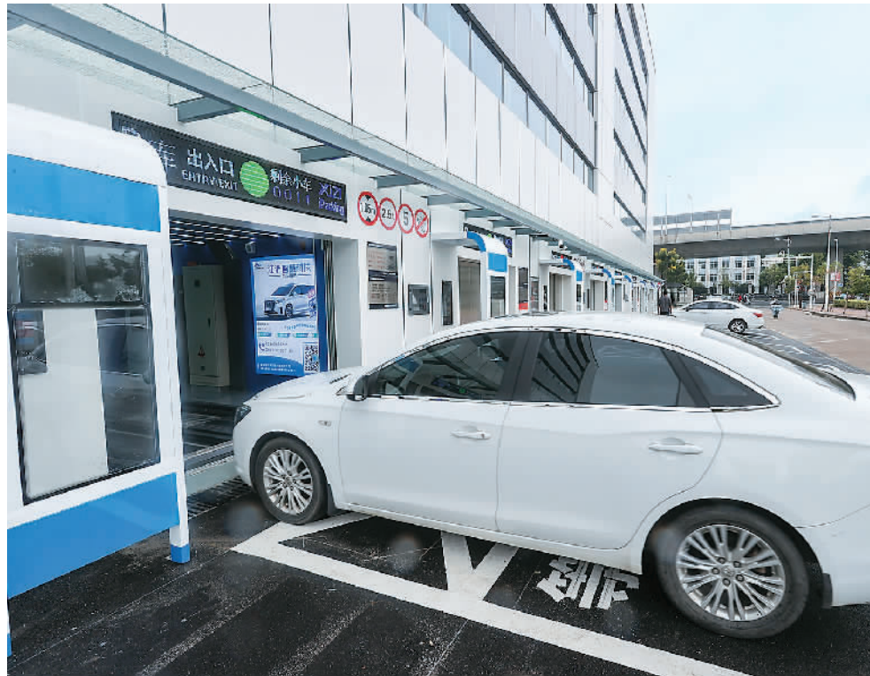
江苏省淮安市淮阴区体育馆路南侧立体停车场借助车牌及人脸识别等取车方式,减少车主寻找泊位的时间,同时实现驾驶人停车过程的免操作、自动计费、无感支付等一体化线上交易功能。图为该立体停车场一角。
