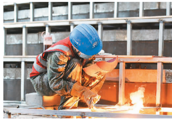
北京城市副中心近年保持较高投资强度，重点项目建设正酣。图为日前施工现场。新华社记者 郝建伟摄
