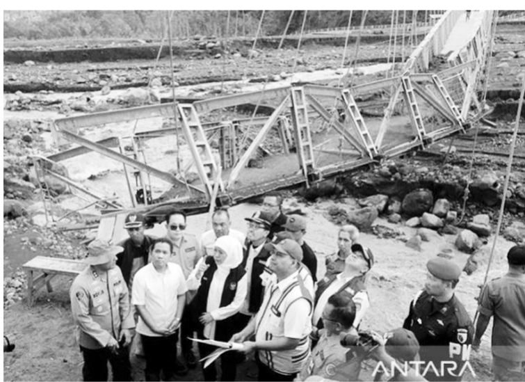
东爪哇省府重建Kaliregoyo桥梁 东爪哇省府定下指标,南海漳县Kaliregoyo桥梁的重建工作时间,必须在2个月内完成。
