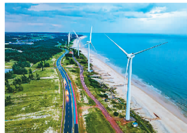
6月24日，海南省文昌市沿海环岛旅游公路旁，风电机组林立。 蒙钟德摄（人民视觉）
