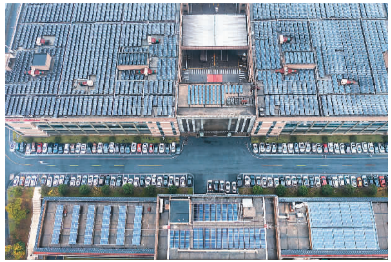
浙江省杭州市临安区金马工业园区内的一家企业，在屋顶上安装了光伏发电设备。 新华社记者 徐昱摄
