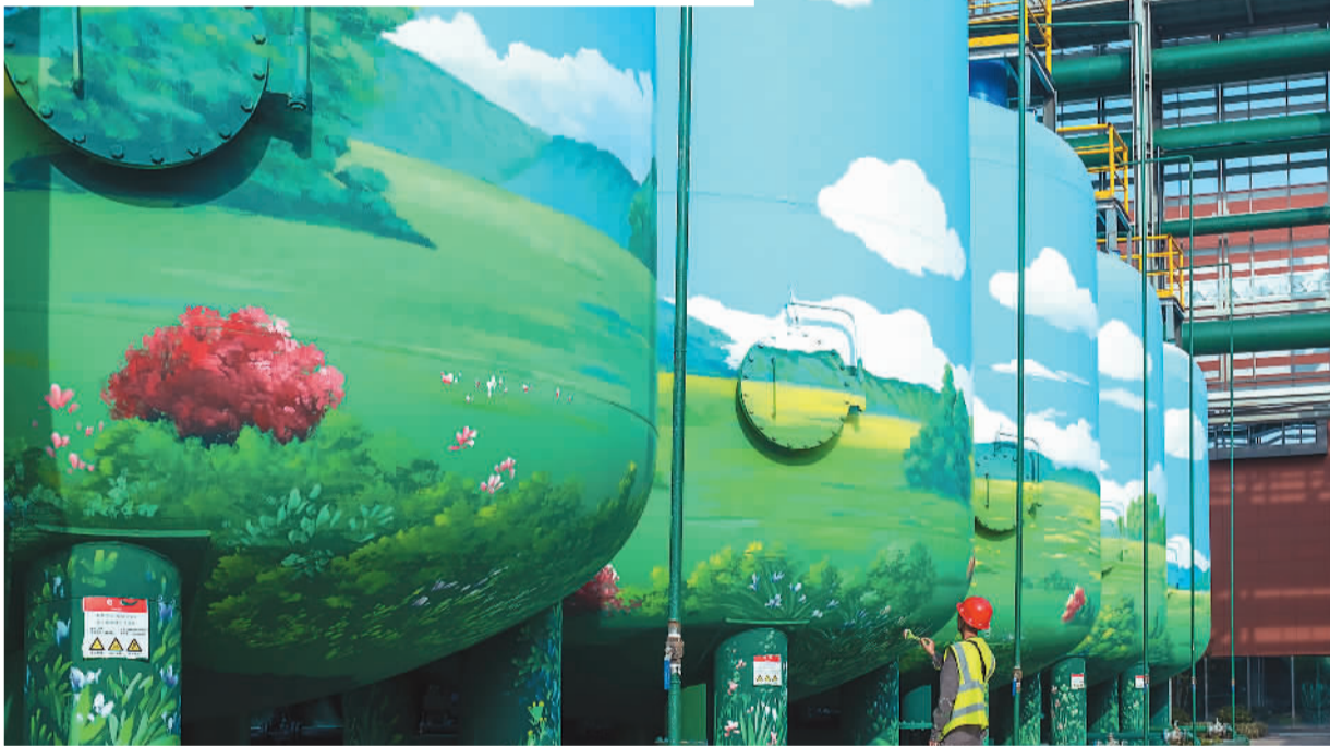
▼6月12日，位于安徽省马鞍山市的花园式生态都市钢厂——中国宝武马钢特钢厂区，施工人员正在对露天设施进行彩绘。 罗继胜摄（人民视觉）
