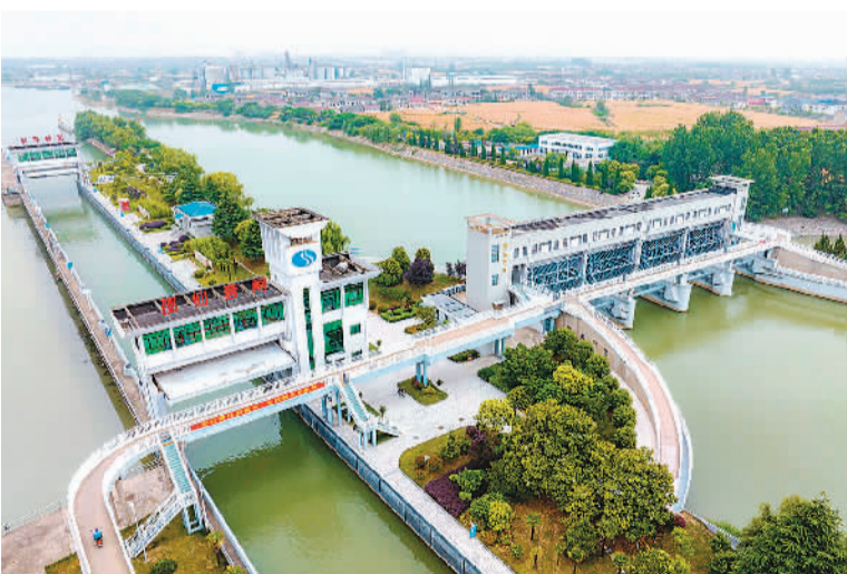
位于江苏省扬州市江都区的南水北调东线一期工程邵仙套闸、邵仙闸。
