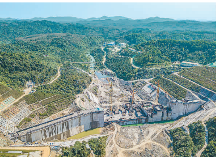
位于海南省南渡江中游的迈湾水利枢纽工程。
