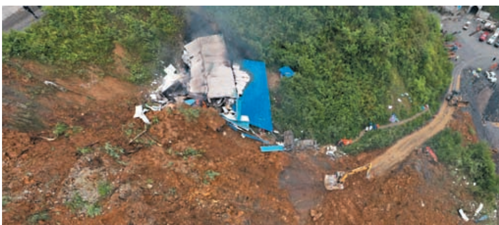
◆山體垮塌現場受損的工棚，不遠處救援人員正抬送一名獲救人員。
