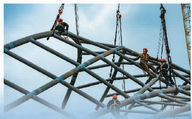
海南琼海文体中心加紧施工。蒙钟德摄（人民视觉）
